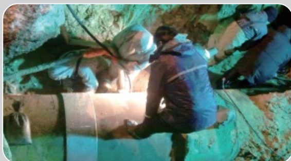
▶ 상수관로 누수 보수공사
